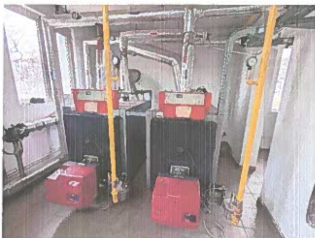
Poza 4. Poză din centrala termică, se observă cele două cazane care asigură încălzirea și boilerul pentru stocarea apei calde de consum
